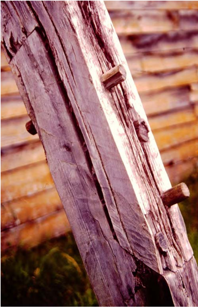
Imagen 7. Arbotante en la iglesia de Nercón, Castro (fuente: el autor).
